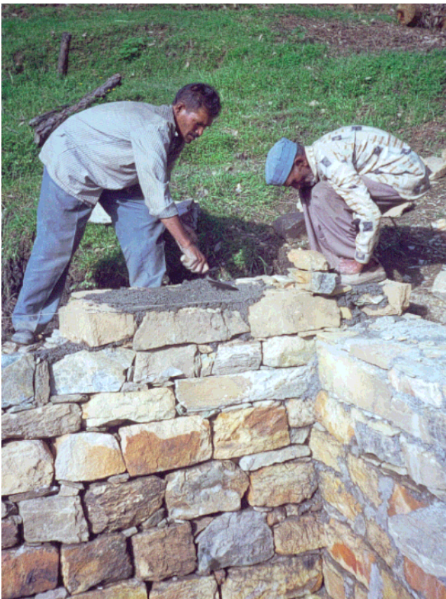
Konstruktion af en regnvandstank.
